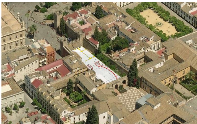
Simulación de la ubicación del Corral de la Montería en los Reales Alcázares de Sevilla
