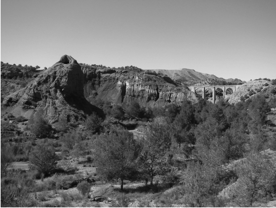
1. Acueducto de los Cinco Ojos, Aspe. Ayuntamiento de Aspe.
