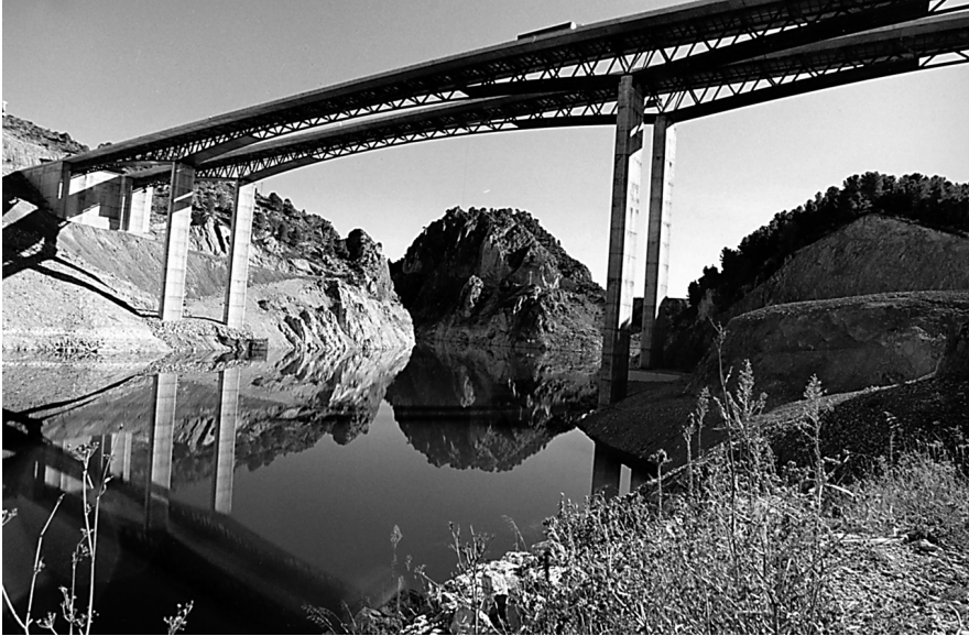
6. Viaducto del Embalse, Minglanilla-Caudete de las Fuentes.
