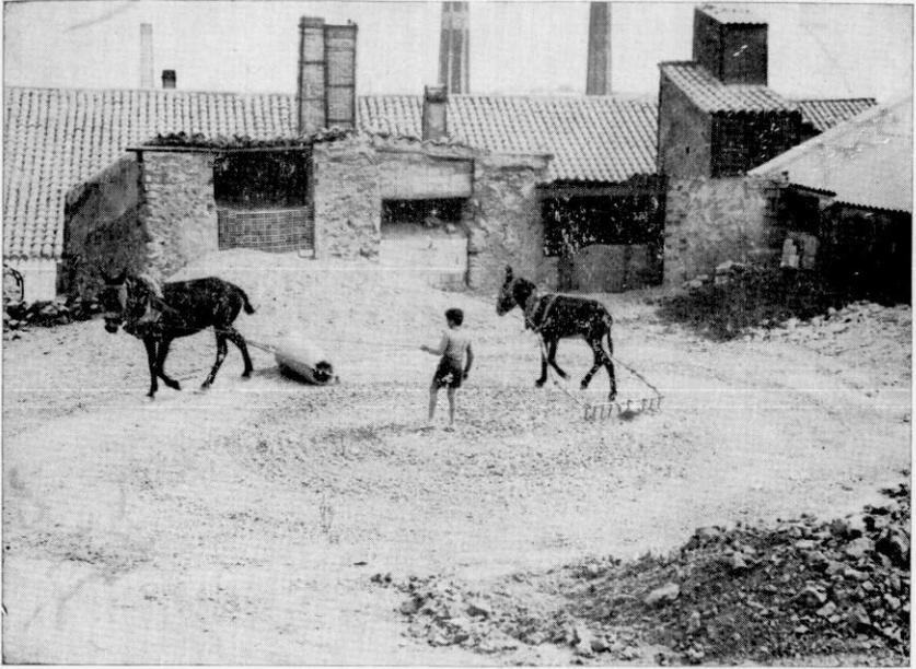
Figura 1.—Rastrillado de la arcilla en la era de una fábrica tradicional.
