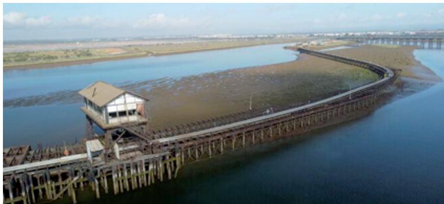
Figura 7. Viaducto original de James y Pring ensamblado al ramal de Arrol, con la caseta de la oficina-puente y Corrales de fondo. Fuente: www.huelvainformacion.com
