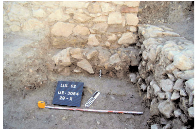
Fig. 3. Appareillage des murs.
