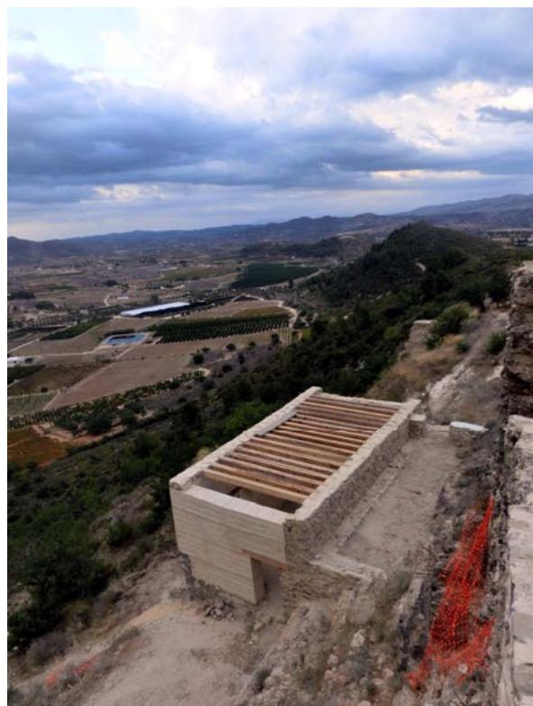
Fig. 15 Cubierta del *pastador* y consolidación de la *recambra* (C3)
