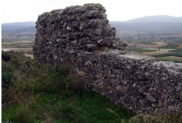
Fig. 3 Parapeto aspillerado del s. XV conservado en su totalidad hasta su acabado en albarda
