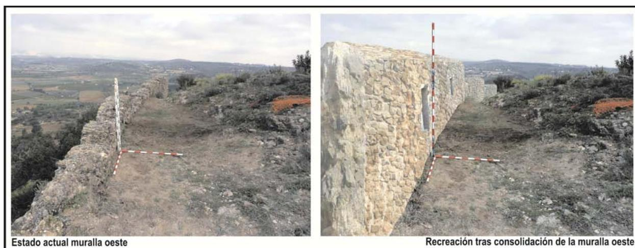
Fig. 10 Proyecto de consolidación de la muralla oeste. Imagen del acabado propuesto (Infografía J. Tierno)
