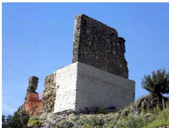
Fig. 7 Consolidación del muro norte de la torre
