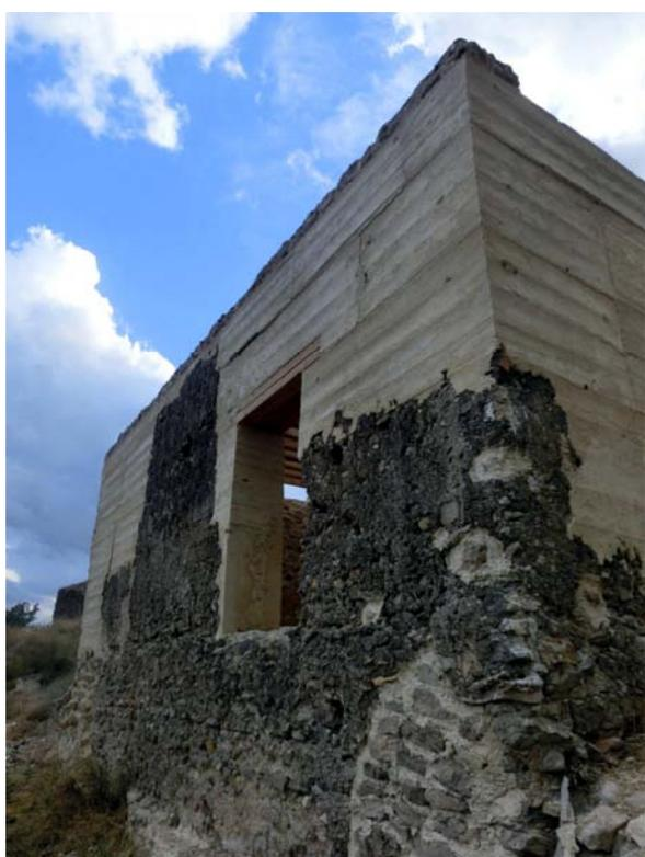
Fig. 14 Fachada este del *pastador* tras la consolidación de los muros de tapial de piedra.
