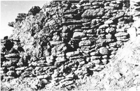
Fig. 32. Pared O del dpto. 23 con restos de enlucido que ha subido la acción del fuego. Año 1999.
