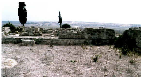
Fig. 27. Pared curvacabecera del salón "G" con hueco para un gran ventanal. Se ve la roza para el asiento de pavimento y el afloramiento de la roca bajo el pavimento (perdido).
