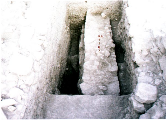
Fig. 4. Muro fenicio UE.1167, parte de un muro de aterrazamiento (campana 2007).
