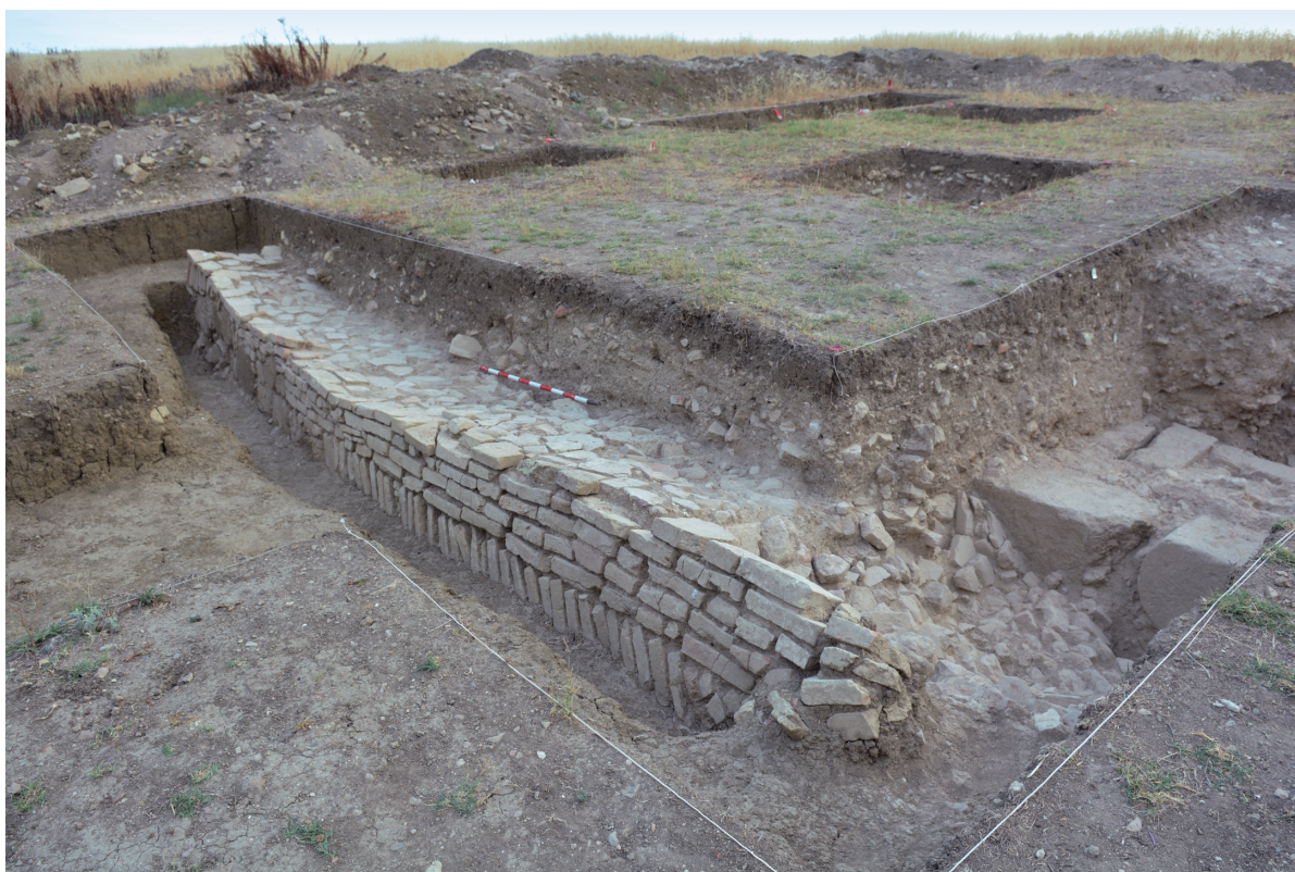
Fig. 8. Plataforma de refuerzo del torreón de la muralla (Corte 1).
