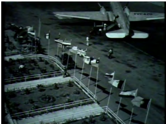
Figura 9. El aeropuerto internacional de Maiquetía.
