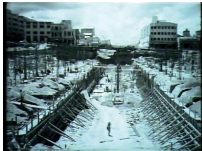
Figura 7. Construcción de la avenida Bolívar, Caracas.
