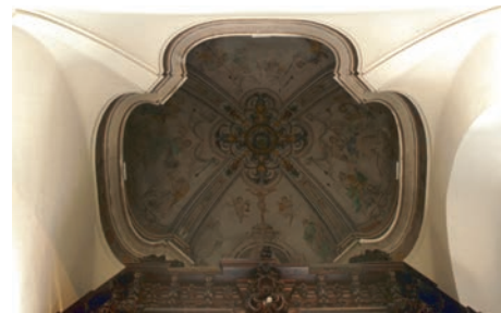
Fig. 6.3. Bóveda cuadrilobulada de la Iglesia del antiguo convento de San Pablo de Sevilla (1691-1709), Leonardo de Figueroa.
