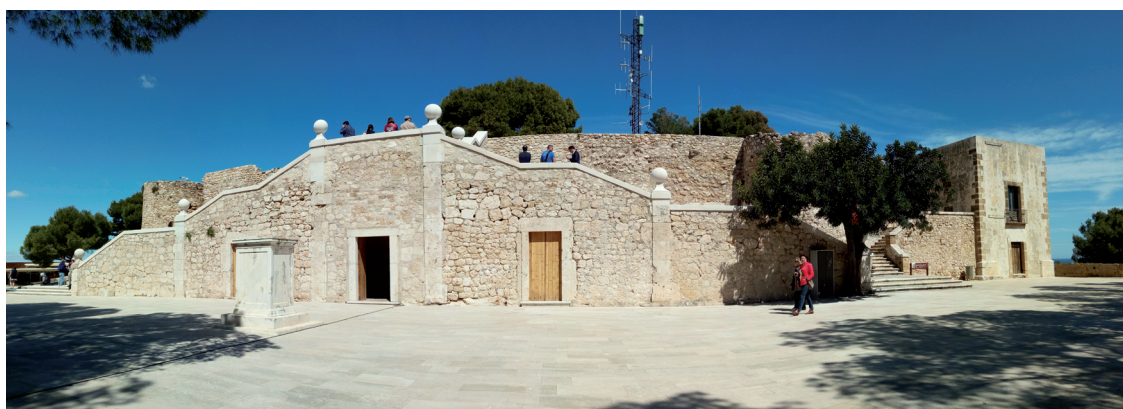
Fig. 6. Estado actual del palacio del castillo de Dénia. Fotografía del autor.
