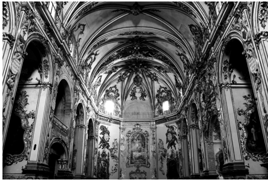
Figura 1. Interior de la Parroquia de San Andrés de Valencia. Post 1751. Fotografía del autor.
