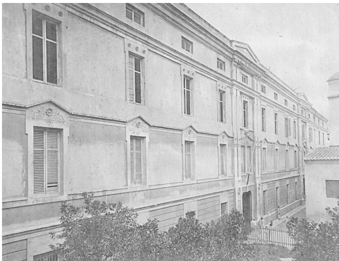
Fig. 4. Fachada principal en 1907. Foto de Barberá Masip, Archivo de la Diputación de Valencia.
