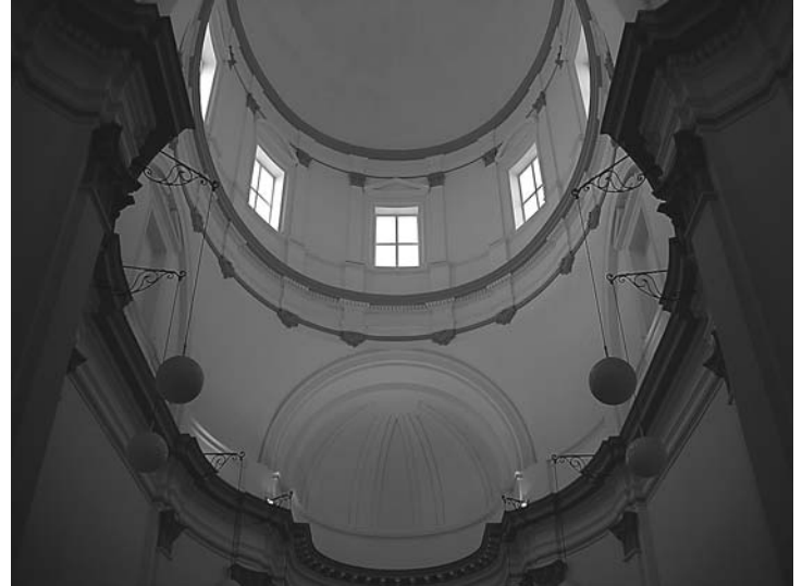
Fig. 11. Arranque de la cúpula de la citada capilla de Santo Tomás de Villanueva.
