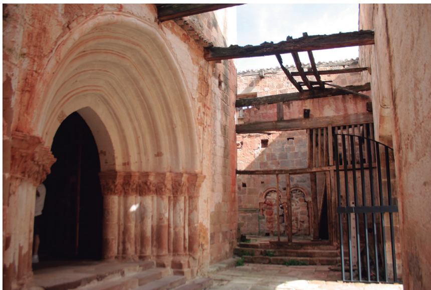
8. Portada románica de acceso al templo y esquina NO de la antigua galería porticada vista desde su interior, con restos de la compartimentación que tuvo después de que se amortizase
