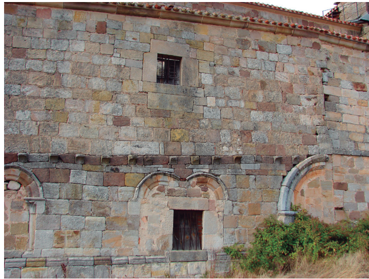
6. Parte del costado meridional del exterior del templo, con restos de la galería porticada románica amortizada para efectuar el recrecimiento en altura e interrumpida al este
