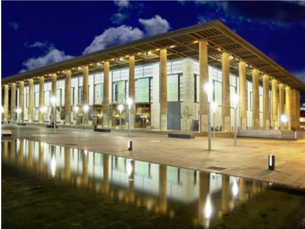
Imagen 5. Auditorio de Zaragoza. Fachada principal y lateral porticadas
