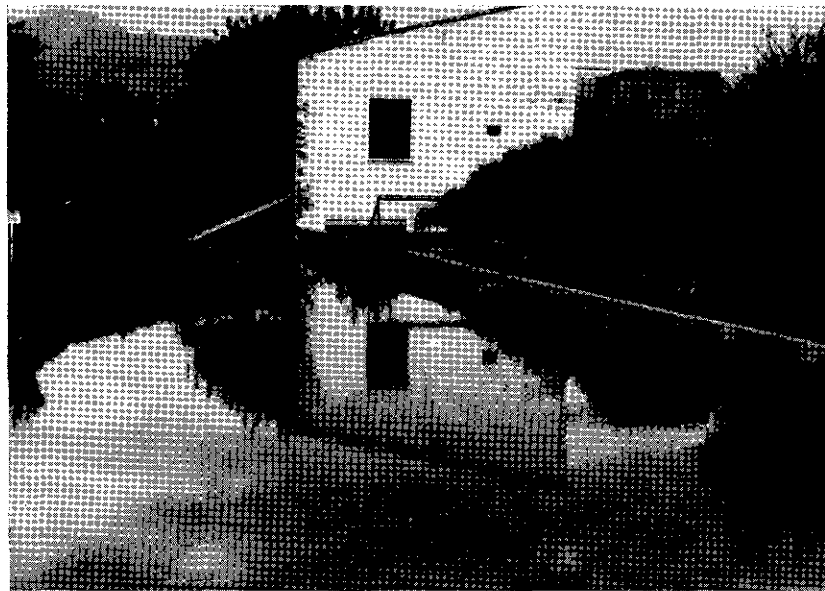
Fig. 2.—Fuentelarreina («Font del Molí»). Manantial con galería de captación o foggara (la boca rectangular, al fondo del estanque) para el riego de arrozales en Castellón. A la derecha, comienzo de la acequia.
