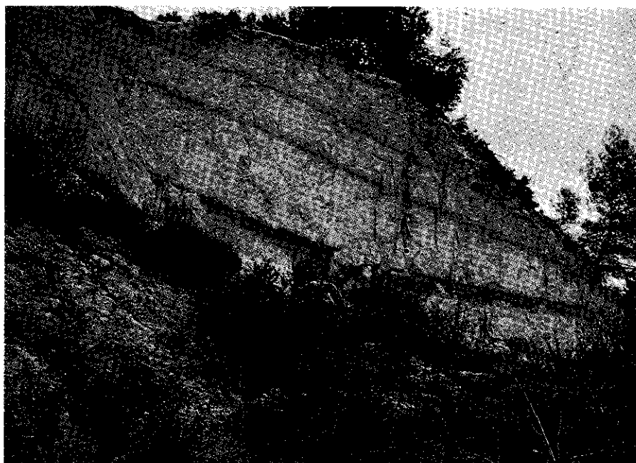
Figura 1.—Cicatriz del deslizamiento del Mas de Jordà. Bloque a punto de deslizar.
