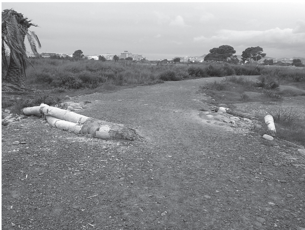
Figura 8. Recuperació de l'illa de la desembocadura del Palància per al DPH. L'actuació ha consistit en derrocar les construccions que ocupaven l'espai. S'han respectat els arbres que hi havia a les parcel·les, s'ha tancat al trànsit la carretera que comunicava el Port de Sagunt amb Canet i s'han habilitat senderes per a vianants. En primer planòl arc decoratiu construït en fang i canyes, que emmarca una de les senderes i que ha caigut. Immediatament darrere es pot veure una de les llacunes excavades, que s'han omplert d'aigua del freàtic i s'han colonitzat per les canyes ( Arundo donax ), vegetació invasora.
