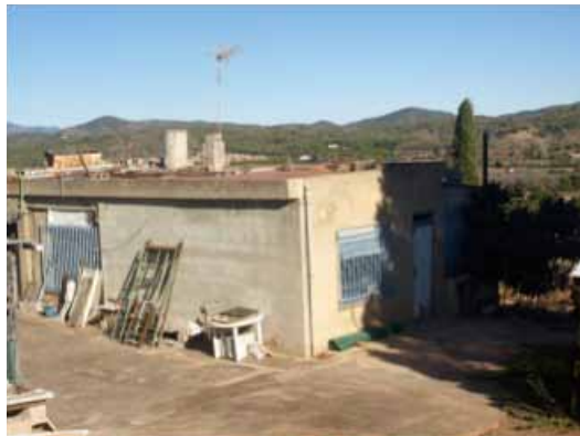
Figura 14. Vivienda de autoconstrucción muy elemental (Camí de la Costera). Fotografía E. Burriel, diciembre 2017.
