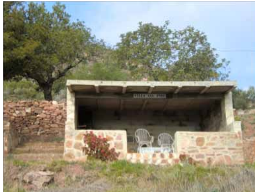
Figura 13. Construcción inicial situada más arriba del Balcó de la Peña que quedó paralizada al clasificarse como suelo no urbanizable protegido en el PGOU de 1994. Fotografía A. Revert, marzo de 2012.
